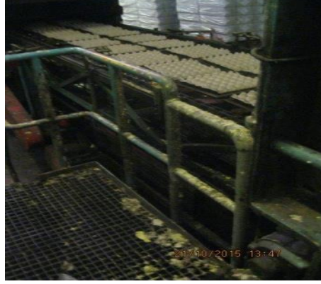
Sonra (korkuluk eksliği tamamlanmış)
