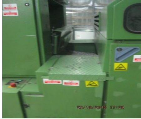
Sonra (korkuluk eksliği tamamlanmış)
