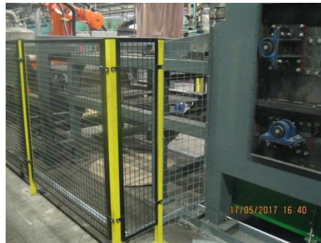
Sonra (Açık kalan kısım kapatıldı)
