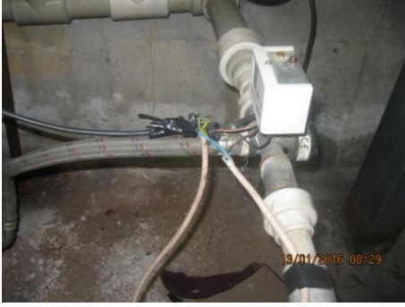
Önce (Elektrik bağlantı kısımları açıkta kalmış)
