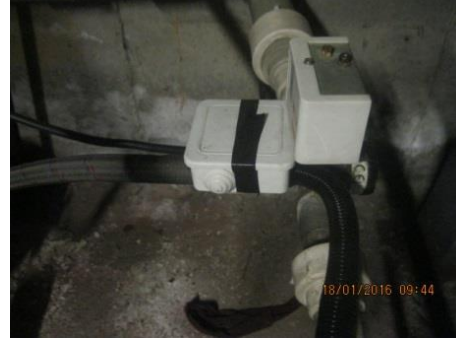
Sonra (Elektrik bağlantı kısmının izolesi yapıldı)
